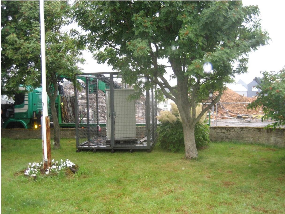
Mynd 2. Farstöðin í garði við Einholt. Á myndinni sést í framkvæmdasvæðið.
